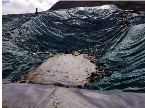
Fotografía 10. Celda de emergencia
