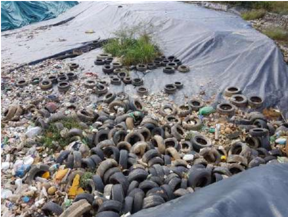
Fotografía 9. Deslizamiento de residuos
