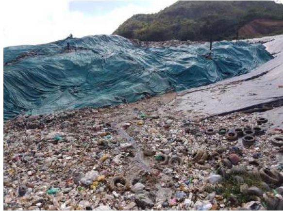
Fotografía 8. Deslizamiento de residuos
