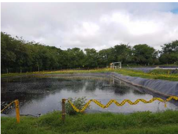
Fotografía 17. Lagunas de oxidación
