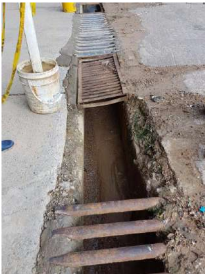
Fotografía 5. Canal de Aguas Lluvias
