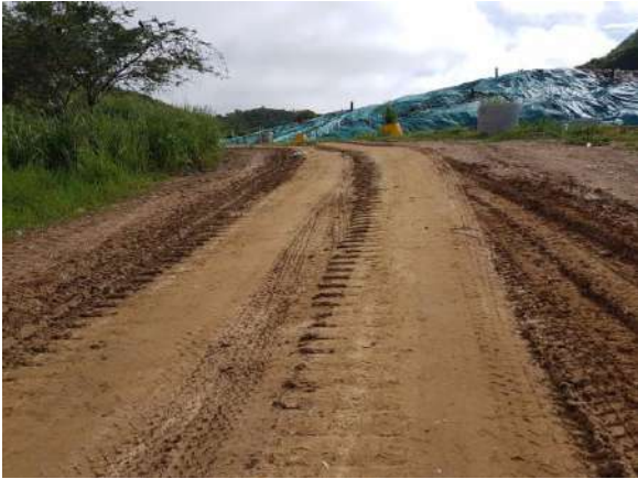
Fotografía 7. Vía de acceso a celda de Disposición
