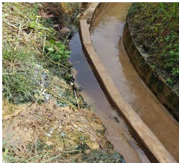
Fotografía 16. Canal de aguas lluvias
