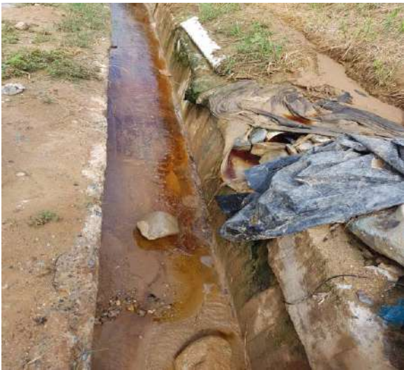
Fotografía 15. Canal de aguas lluvias
