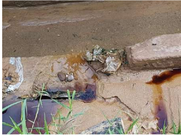
Fotografía 14. Canal de aguas lluvias
