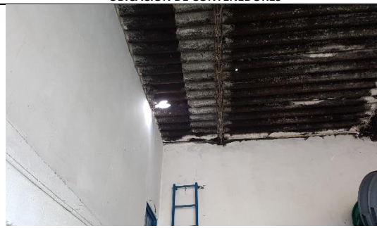
ESTADO DE CUBIERTA O TEJADO
