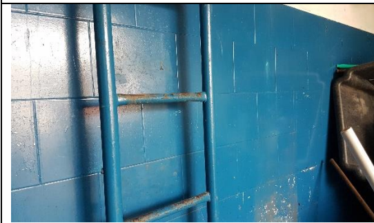
ESTADO DE PAREDES
