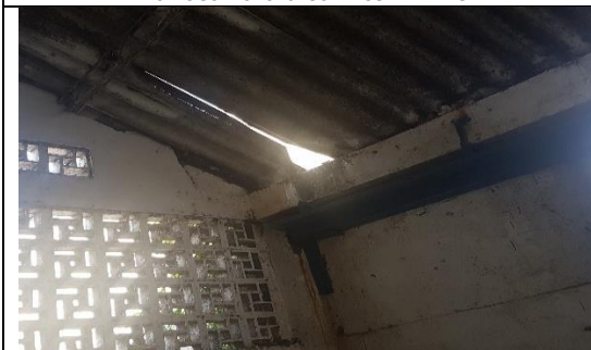
ESTADO DE LA CUBIERTA
