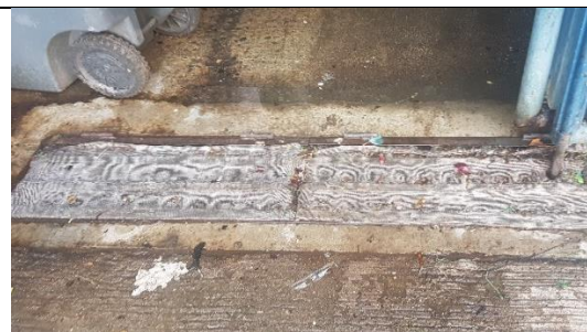
CUNETA RECOLECCIÓN DE AGUAS NEGRAS
