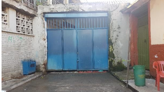
PUERTA DE INGRESO CHUTE
