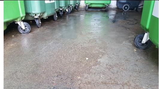
ESTADO DE PISOS
