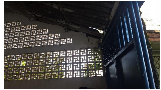
ESTADO DE TECHOS
