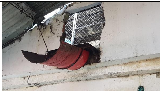
DUCTO DE EVACUACIÓN DE RESIDUOS
