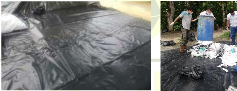
Fotografía 3. Disposición de los residuos sólidos en la plataforma
