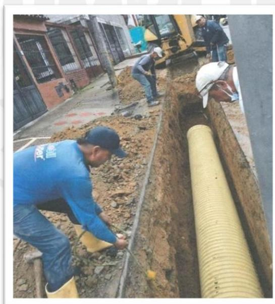
Perforaciones para la instalación de la tubería de alcantarillado Barrio Ambalá
