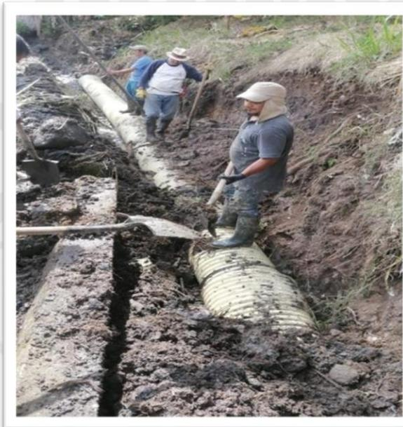
Instalación de la tubería para el manejo de aguas lluvias de la Vereda Santa Teresa
