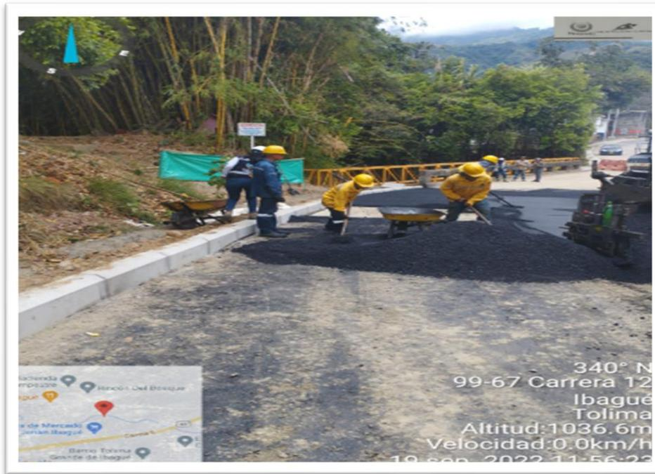
Con una ejecución de 95 % y una inversión de 4.116 millones de pesos se han realizado actividades pavimentación desde el puente Chípalo hasta Carrera 5, previa instalación de sardineles, de señalización de pozos y senderos peatonales en obra, trabajos de profundización de redes,
