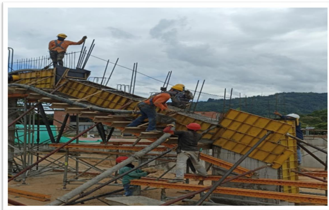
Obras piscinas de la 42
