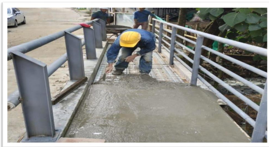
Puente peatonal Barrio la Florida
