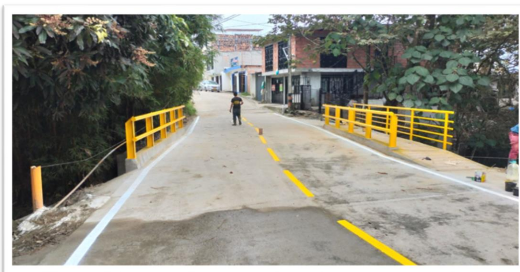
Puente vehicular Barrio la Florida
