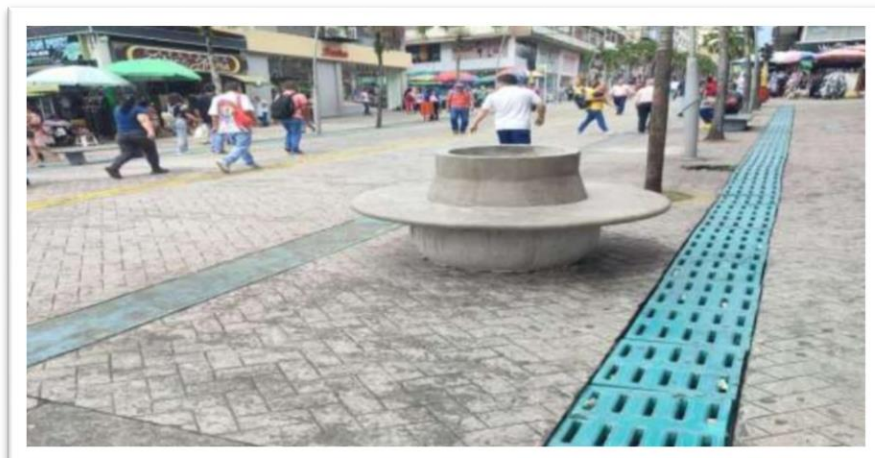
Banca en concreto - olla de barro carrera tercera
