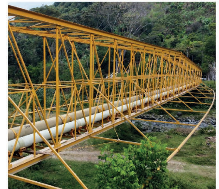
Viaducto sobre el río Combeima
