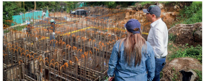
Proceso de modernización de la planta de tratamiento Chembe
