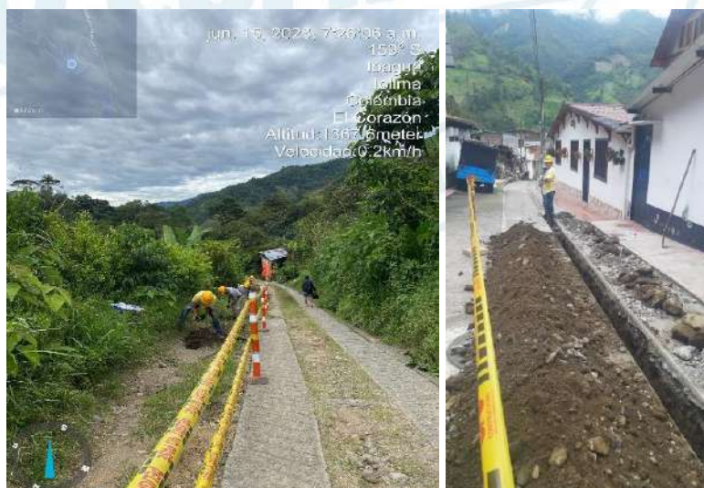
Demolición de concreto, excavación y señalización
