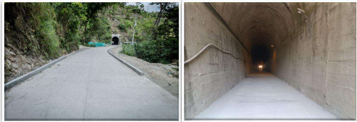
Vía Túneles Pavimentación Concreto Hidraulico Fuente: El IBAL S.A. E.S.P Oficial
