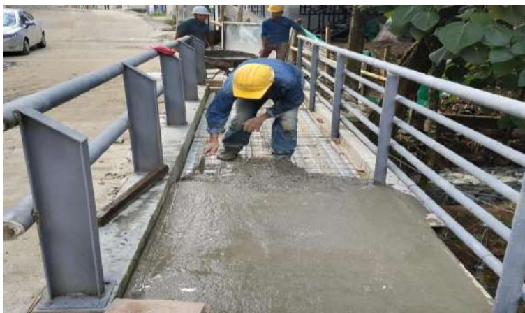
Puente peatonal Barrio la Florida
