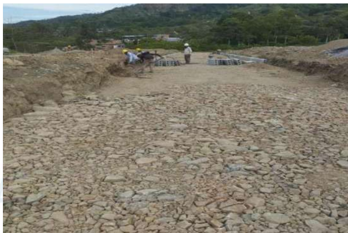
Obras de urbanismo para reubicación hato de la virgen.
