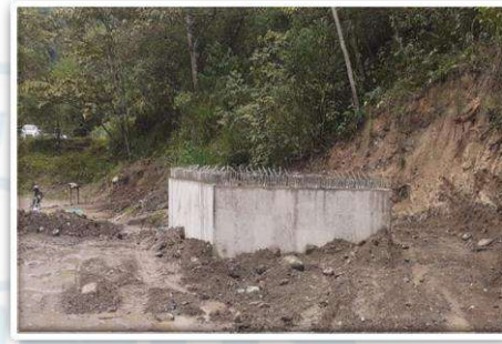
Fase 1 – Fase 2 K6+540 Construcción Cámara Válvula de Sobreve Fuente: El IBAL S.A. E.S.P Oficial
