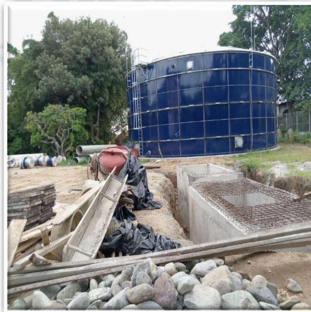
Llegada Tanque Sur (Conducción) Construcción Cámaras Fuente: El IBAL S.A. E.S.P Oficial
