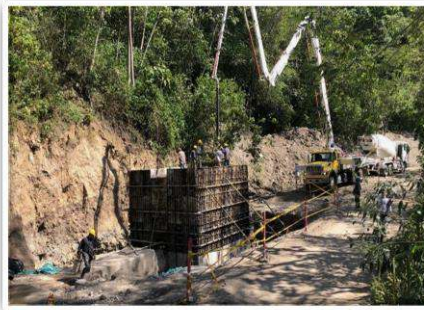
Fase 1 – Fase 2 K6+540 Construcción Cámara Válvula de Sobreve Fuente: El IBAL S.A. E.S.P Oficial
