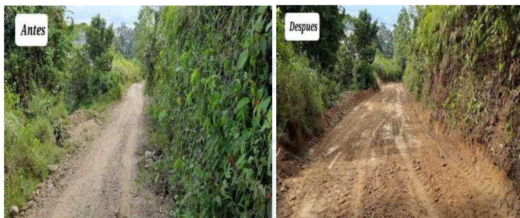
Mantenimiento del eje vial en la vereda Martinica Media y Alta Corregimiento El Totumo
