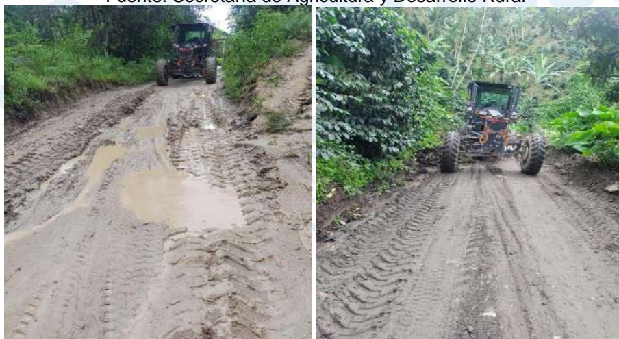
Mantenimiento del eje vial en la vereda La Loma de Cocora Corregimiento Coello Cocora.
