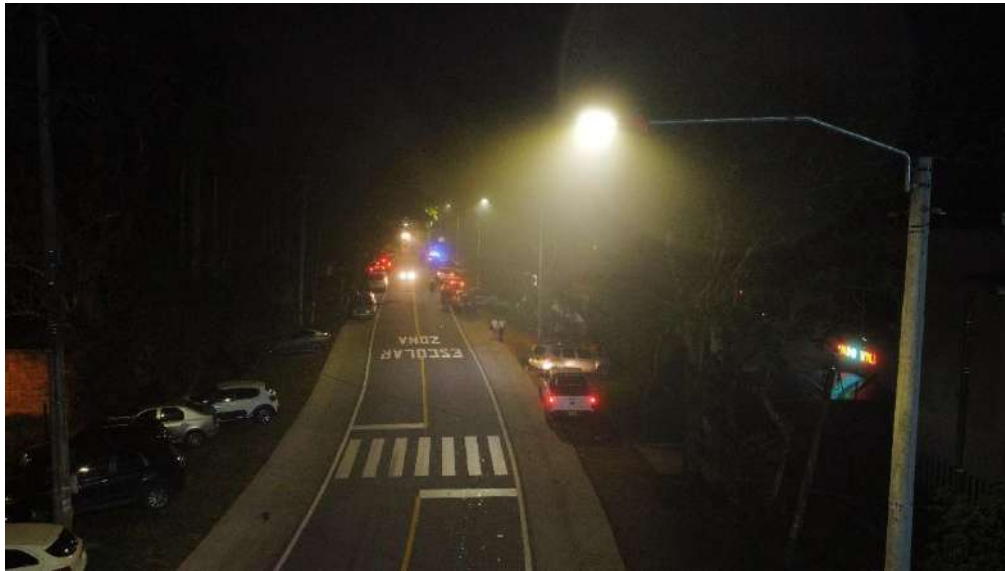
Imagen 4. Modernización LED Corregimiento el Totumo
