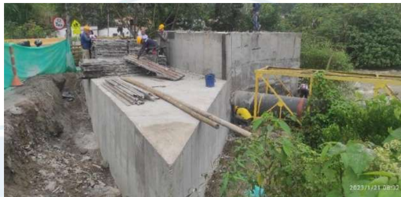
Construcción de más de 80 anclajes Fuente: El IBAL S.A. E.S.P Oficial
