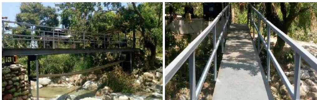
Puente metálico sobre la Quebrada la Chumba Fuente: Secretaría de Agricultura y Desarrollo Rural
