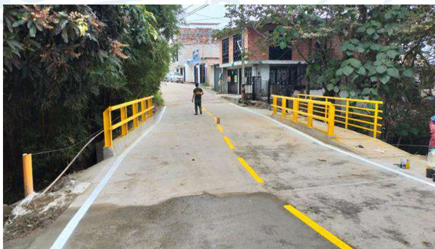
Puente vehicular Barrio la Florida
