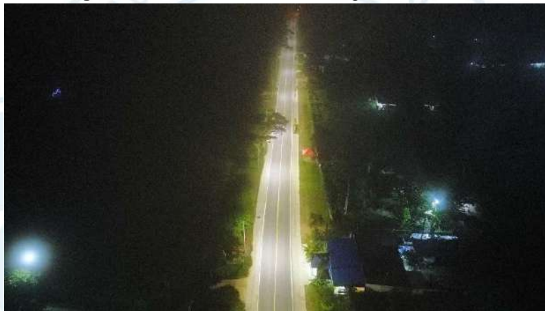
Imagen 5. Modernización LED Corregimiento el Totumo
