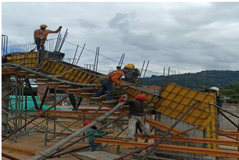
Obras piscinas de la 42
