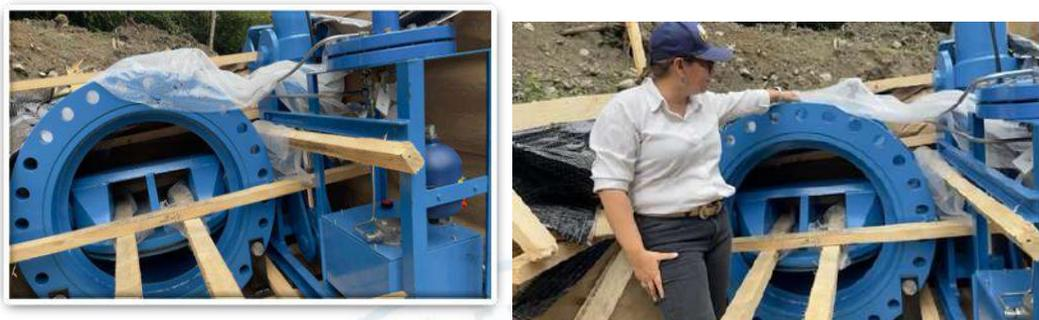
*Ilustración 23. Válvulas de sobrevelocidad*
