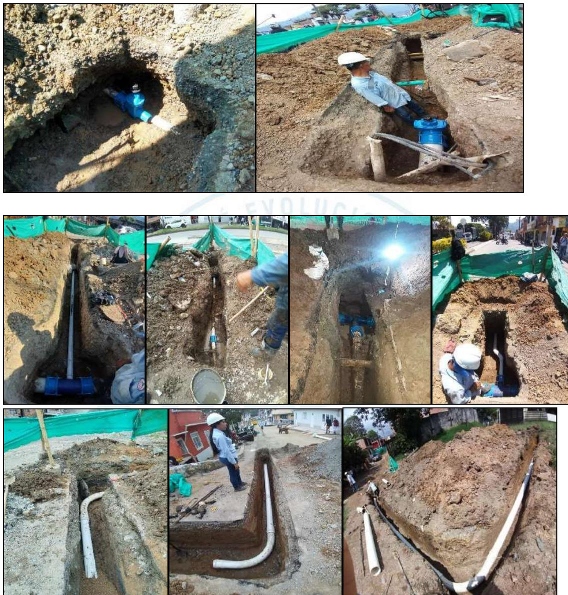
Ilustración 34. Instalación de válvulas y accesorios
