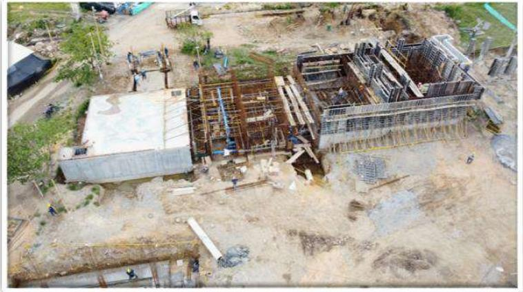
Ilustración 11. Canal de entrada, floculación, sedimentación, filtros y cámara de cloro - PTAP Boquerón
