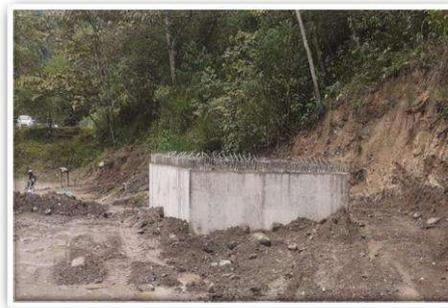
*Ilustración 22. Construcción cámara válvula de sobrevelocidad*
