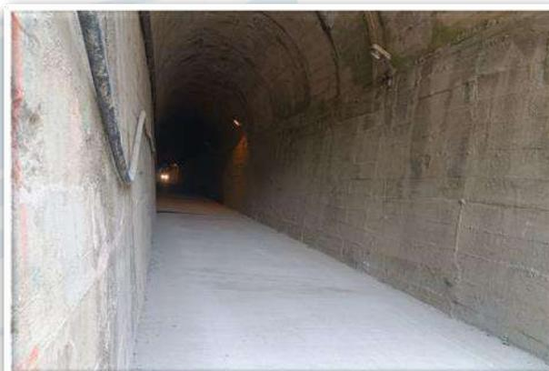
*Ilustración 26. VÍA TÚNELES PAVIMENTACION CONCRETO HIDRAULICO*
