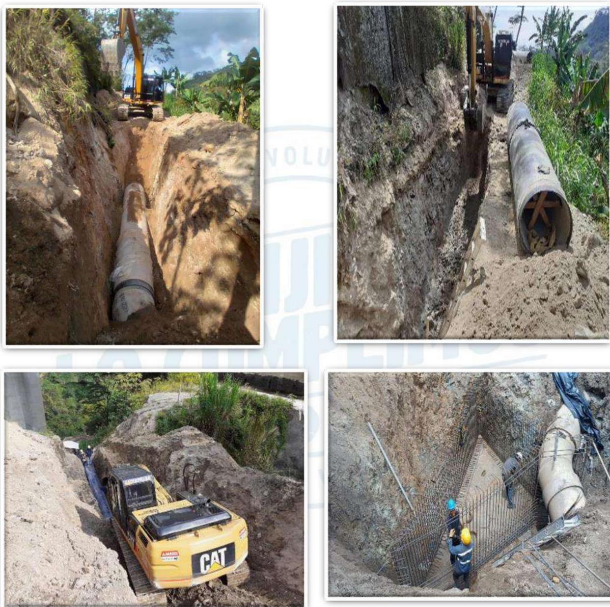
Ilustración 25. INSTALACIÓN TUBERÍA 36" GRP, WSP, CONSTRUCCIÓN CÁRCAMO
