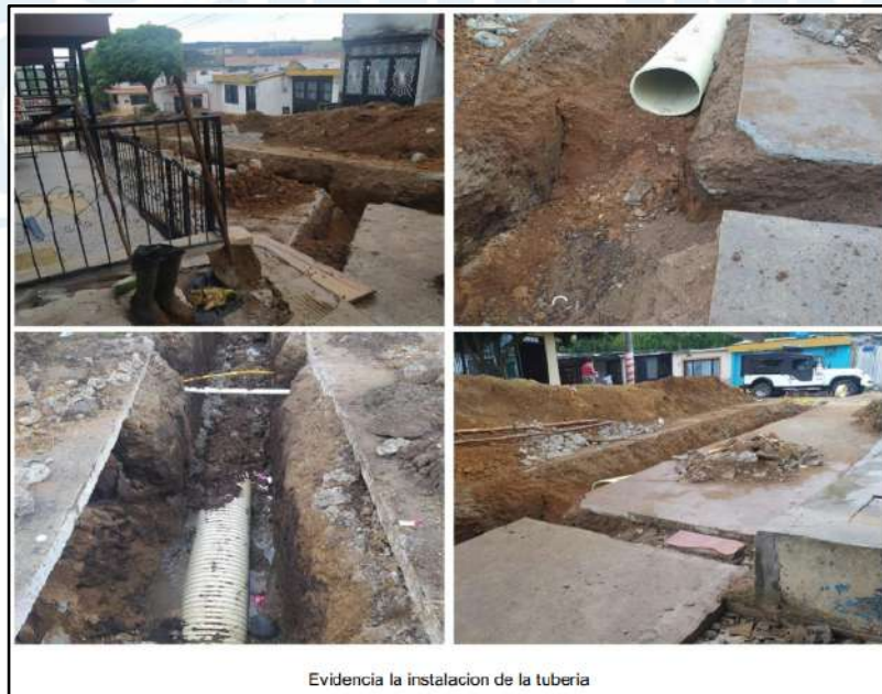
Evidencia la instalación de la tubería
