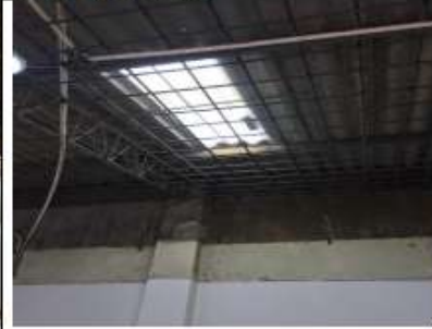
Descripción Rejas seguridad superior construidas salón2
