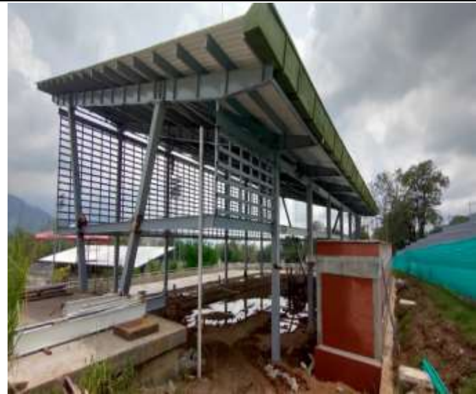
Imagen 1: Fabricación e instalación de canal en lamina galvanizada.
