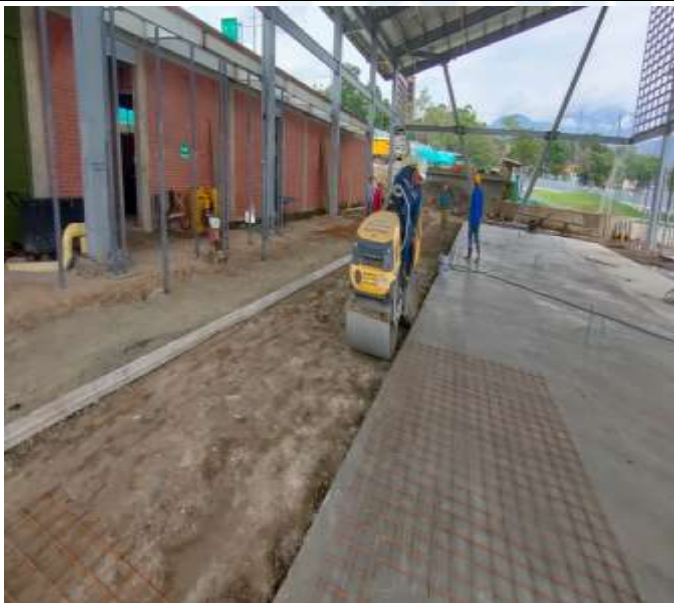
Imagen 3: Conformación y compactación de base granular.
