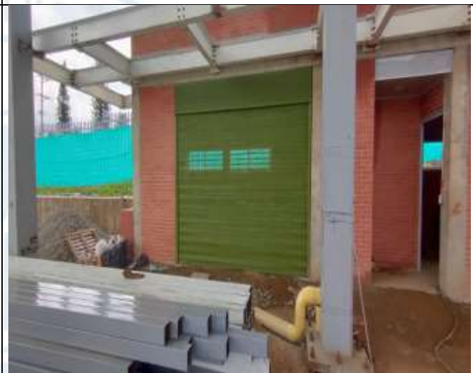
Imagen 8: Instalación de reja principal de cafetería.
