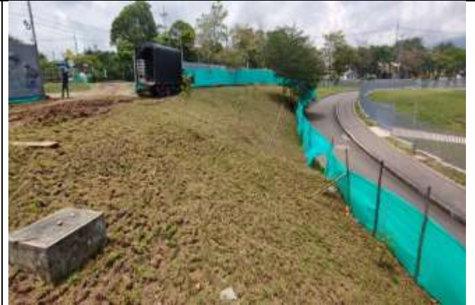
Imagen 6: Siembra de césped en taludes.
