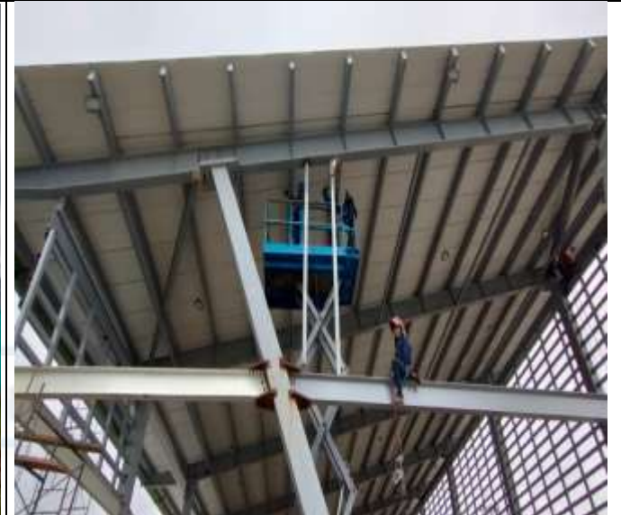
Imagen 2: Fabricación e instalación de módulos para soporte de Celoscreen
