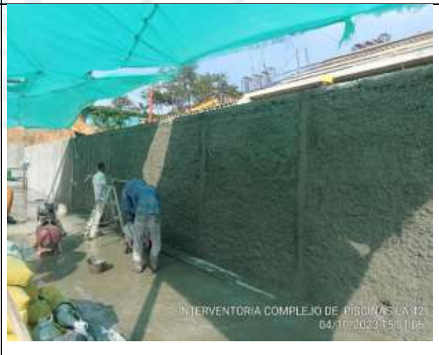
INTERVENTORIA COMPLEJO DE PISCINAS LA 42 04/10/2023 15:31:40
