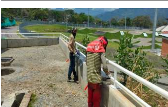
Imagen 5: Aplicación de pintura en baranda perimetral
