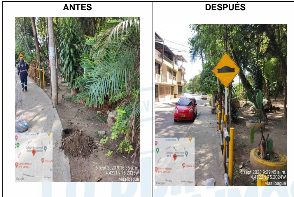
Imagen 10 Señal vertical instalada CRA 2 CL. 59 HDA PIEDRA PINTADA
