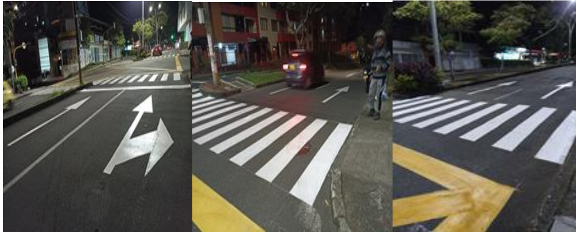
Imagen 14 Intervención paso peatonal calle 37 cra 6
