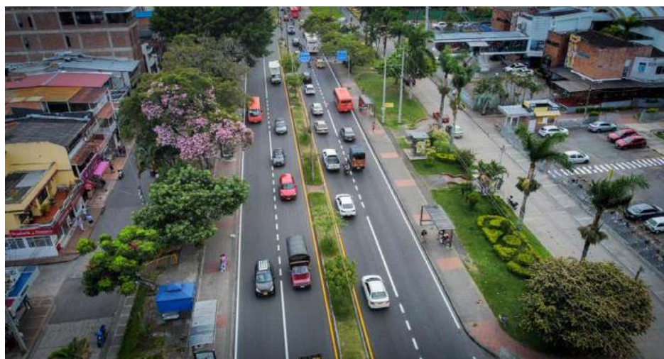
Rehabilitación Cra 5ta. Elaboración propia
