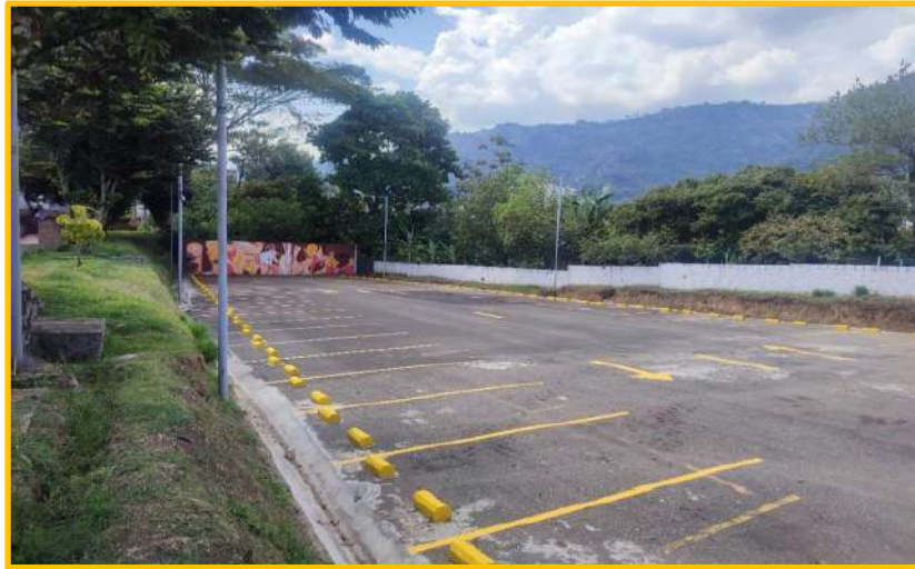
Obras de adecuación parqueadero panóptico
