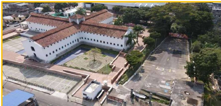
Obras de adecuación parqueadero panóptico
