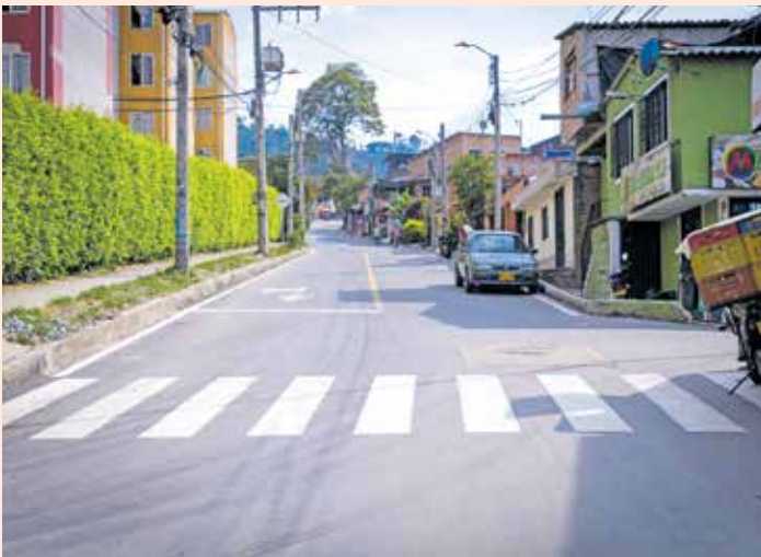
Comuna 13 (Boquerón): 1.392 metros de tuberías renovadas, 1.864 metros cuadrados de pavimentación.
