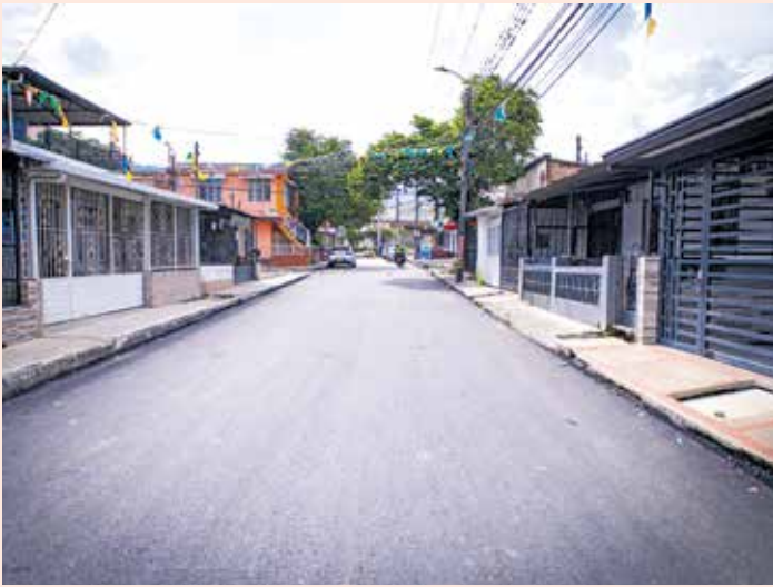
Comuna 12 (Yuldaima): 1.506 metros de tuberías renovadas, 4.127 metros cuadrados de pavimentación.
