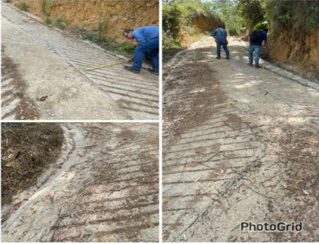
Construcción placa huella Cay Parte Alta
