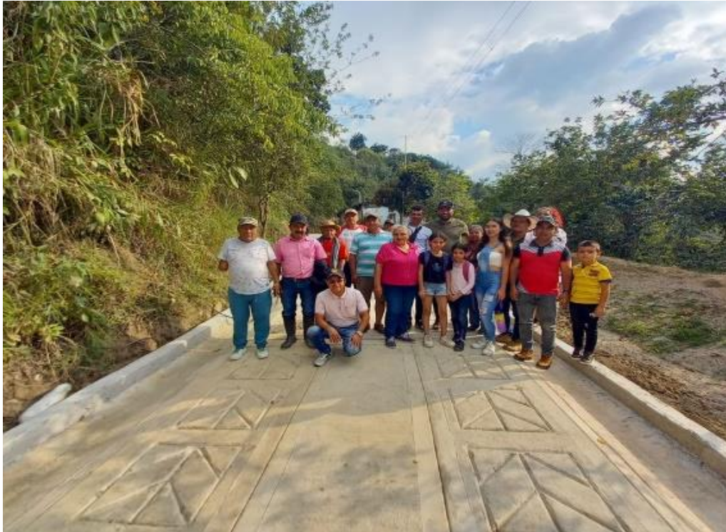
Construcción placa huella Loma de Cócora
