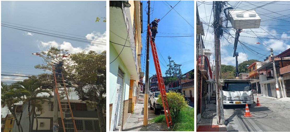
Modernización de 49 luminarias Led
