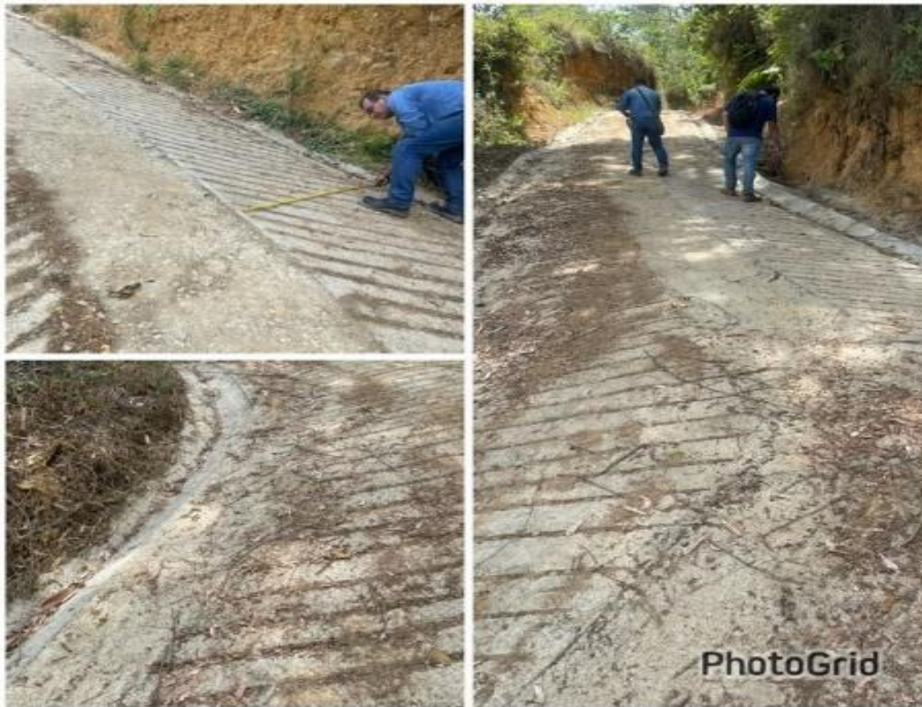
Construcción placa huella Cay Parte Alta
